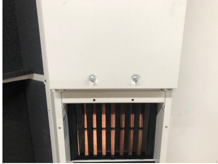
Figure 3 Bovenpaneel handschroeven
