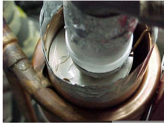
(b): Bevestiging verdeelplaatje bovenin de dwtw-unit.
