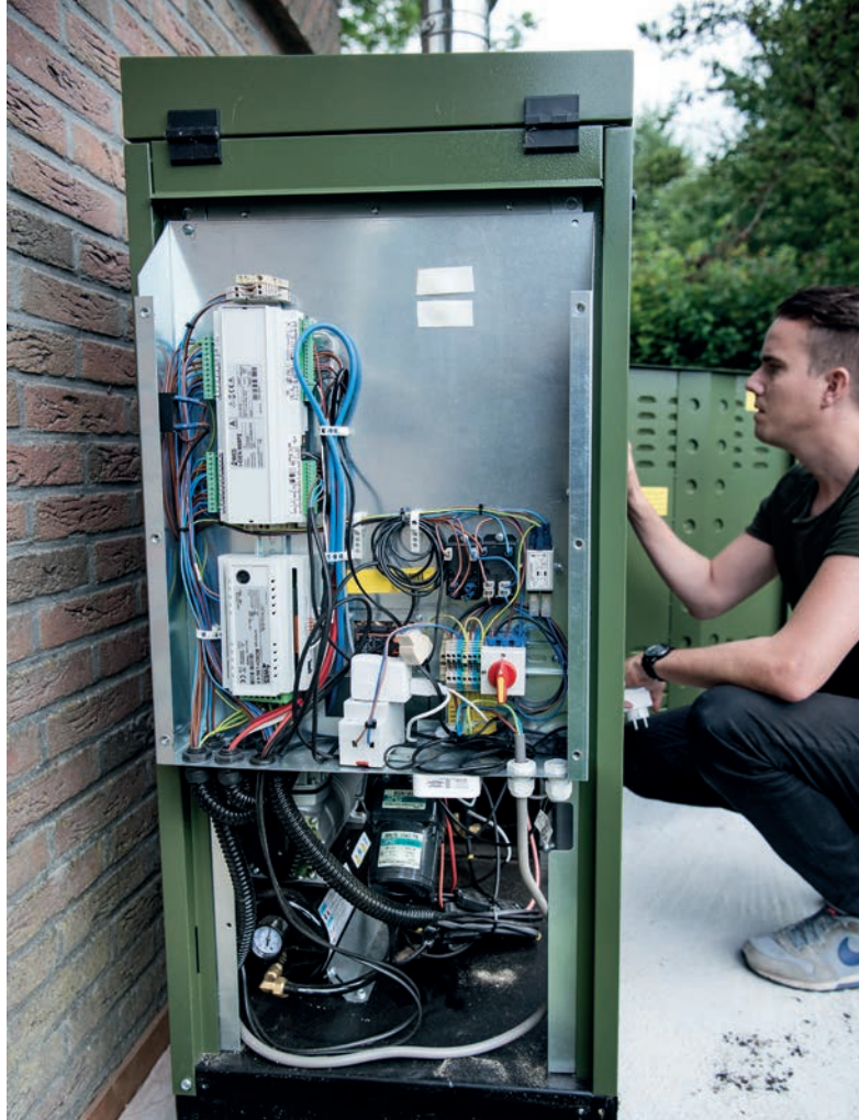
De robuuste en iets minder compacte uitvoering van een pelletketel maakt de vervanging van onderdelen iets eenvoudiger dan bij supercompacte gasketels van tegenwoordig.
