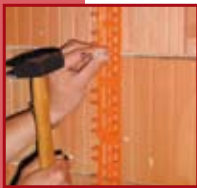
Bevestiging van de VarioRail 16/100 (SWH2)
