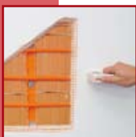
De plaats van de Varioklima-buizen wordt met de leidingzoeker bepaald
