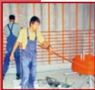
Varioklima-buis in een hand-omdraai gelegd
