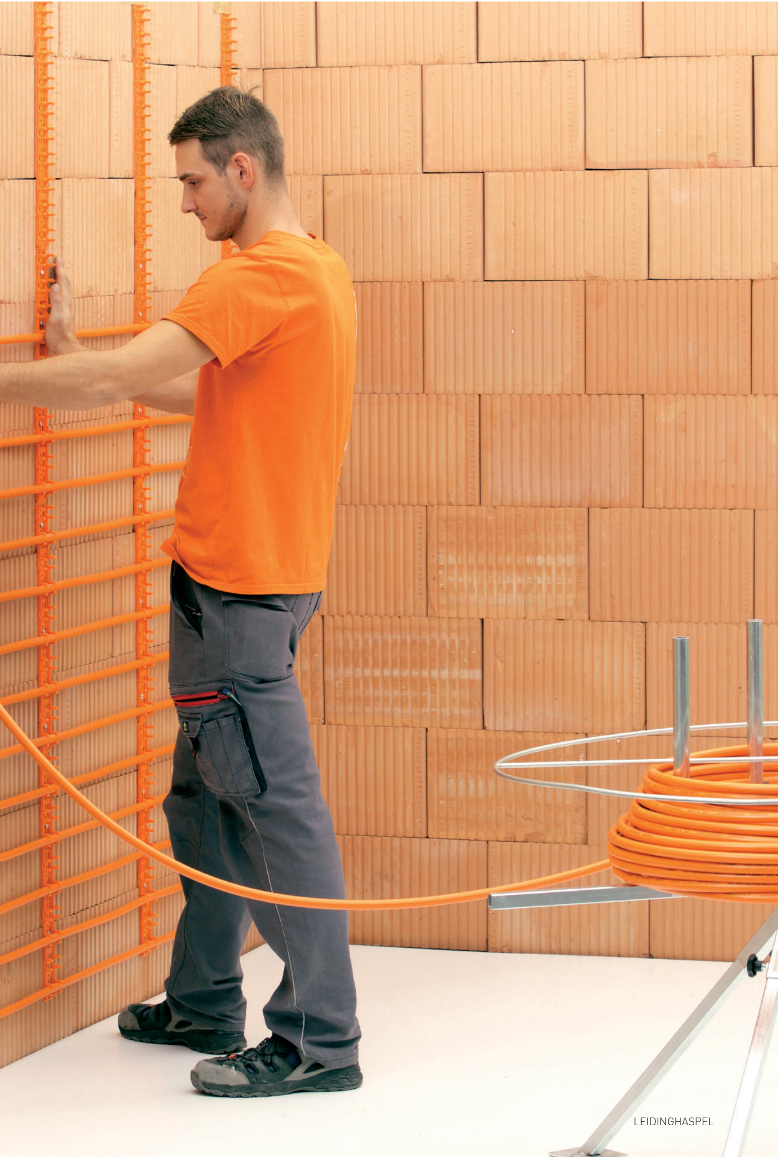
WAND - PLAFOND | VERWARMING - KOELING | PLEISTERLAAG
