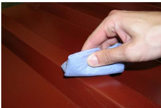
Afbeelding 2: Reiniging v.h. te beplakken oppervlakte
