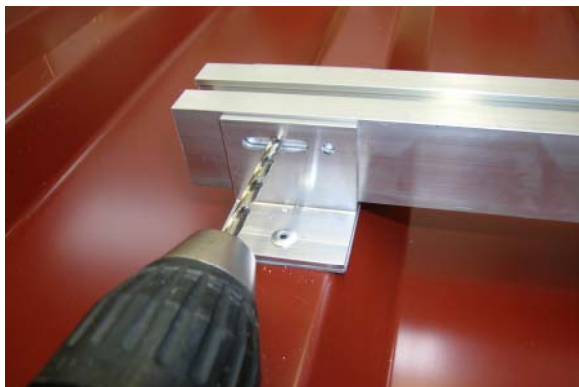
Afbeelding 12: Aanboren draagprofiel
