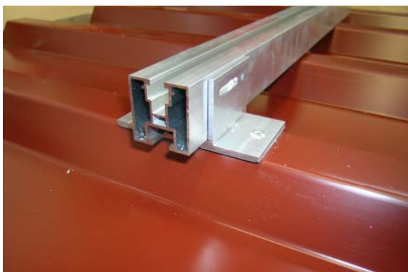
Afb. 11: Inleggen des Draagprofiel Typ IBC 39-o
