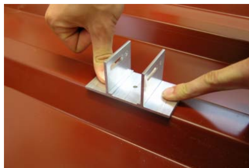
Afbeelding 4: Plakken der TRAPEZIUMKLEMMEN
