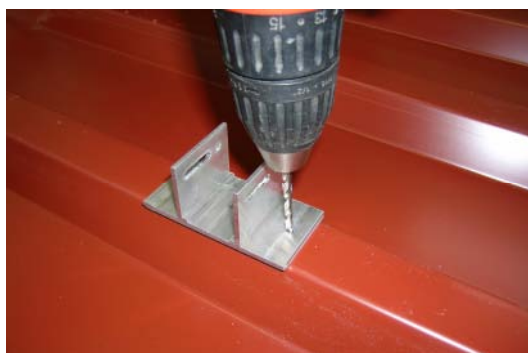
Afbeelding 5: Boren door de dakheid
