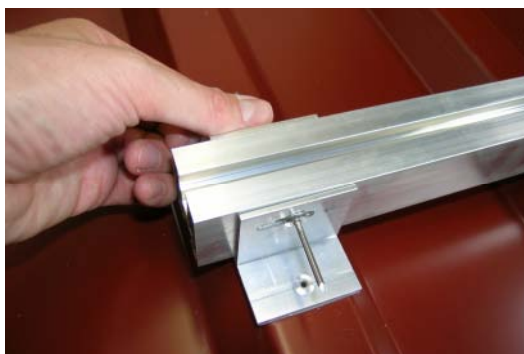
Afbeelding 17: Insteken v.d. 2° platbolkopniet
