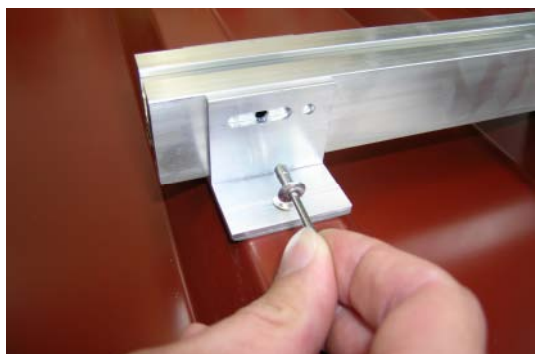
Afbeelding 16: Insteken v.d. 1° platbolkopniet
