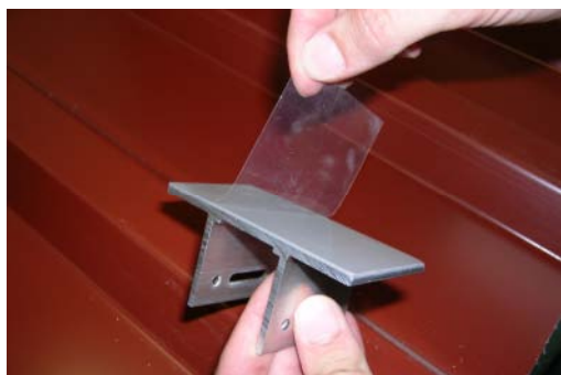
Afbeelding 3: verwijderen v.d. beschermfolie
