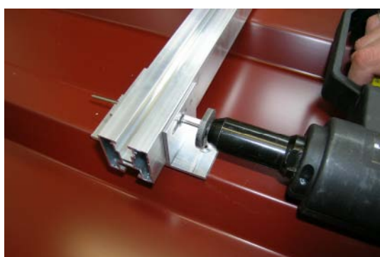
Afbeelding 18.1: Opzetten v.d. klinkopzet
