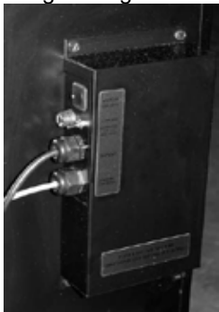
Afb. 4.2 EconoCool® schakelaar op aansluitkast.
